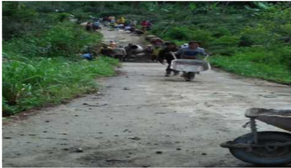
Gambar 11 Rabat Beton Jalan Desa
