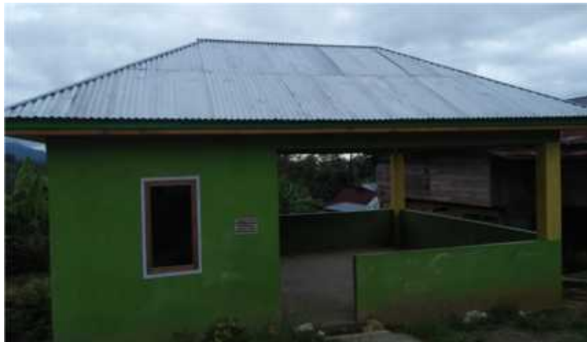
Foto : Pembangunan Posyandu
