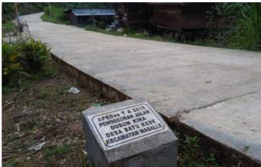
Foto: Pengecoran Jalan Dusun Kira Timur
