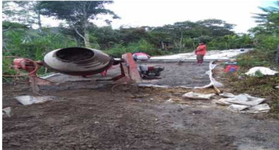
Foto: Rabat Beton Jalan Tani Parandean - Lumika
